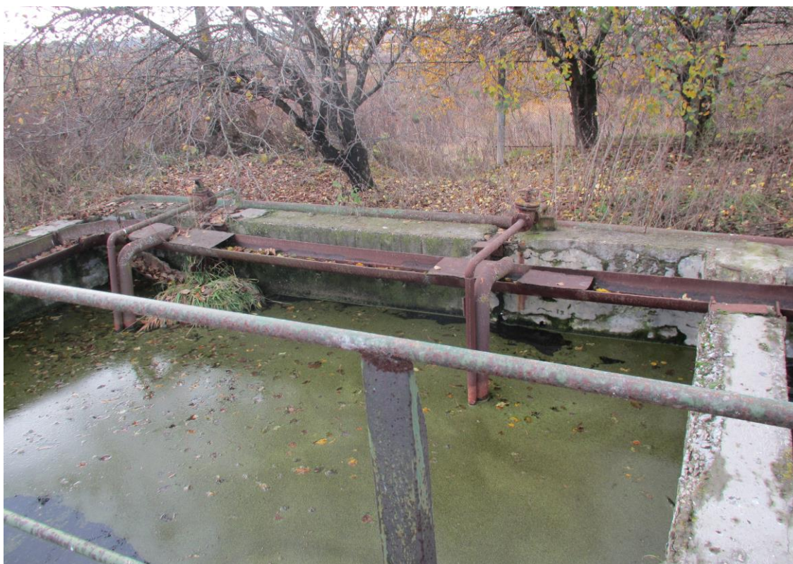
Рисунок 9 – Вторичные отстойники
