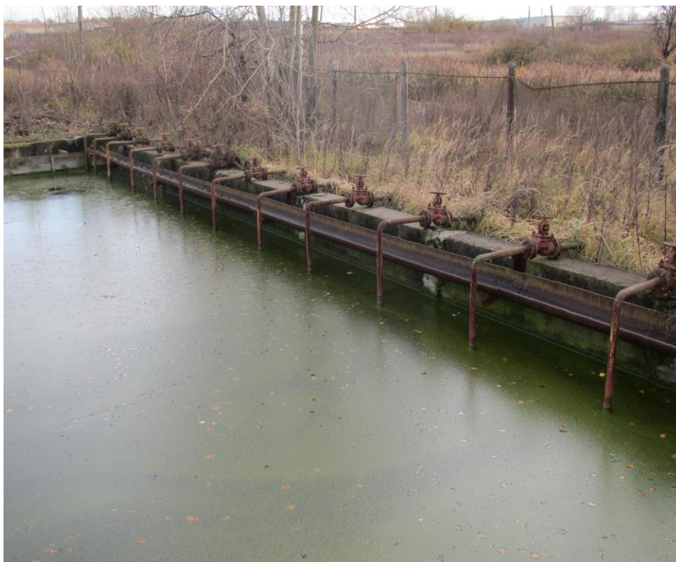
Рисунок 8- Аэротенки
