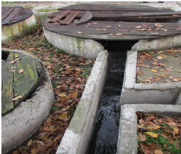
Рисунок 10 – Контактные резервуары
