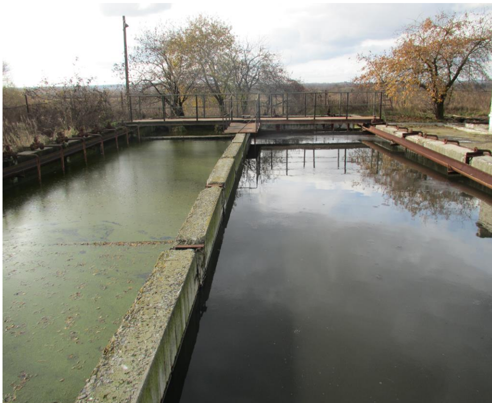
Рисунок 7- Аэротенки
